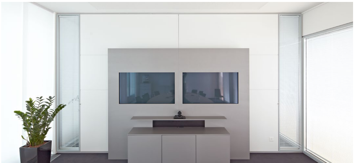
Architekten planen oft mit schmalen Verglasungen als Abschluss der Trennwände
