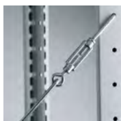
Diagonalstrebe mit Spannschloss
